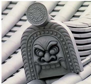
平安建都以来、京都は瓦の一大産地として栄えてきた。第二次世界大戦後は、特殊な手づくりの瓦を中心に生産している。京瓦の種類は700種類以上にのぼり、屋根全体を覆う地瓦より、鬼瓦、軒瓦、ケラバ瓦など役瓦が中心となっている。丈夫で、いぶし銀のように美しい輝きを持つ手づくりならではの風合いが、京瓦の特色である。
