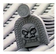
从平安建都以来、京都作为瓦片的一大产地繁盛起来。第二次世界大战后、以生产特殊手工制作的瓦片为主。京瓦的种类超过700种、主要是从覆盖整个屋顶的"地瓦"到"鬼瓦"、"轩瓦"、"袖瓦"等"役瓦"。坚固、具有氧化银般美丽的光泽、于工制作特有的质感是京瓦的特色。
